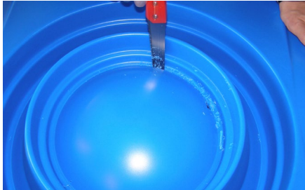
Le long des repères découpe à l'aide d'une égoïne.
