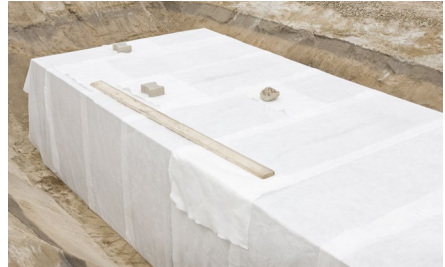
Rausikko Box enrobé d'un géotextile
