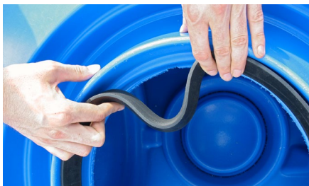
Positionnement du joint pour le raccordement de la canalisation.
