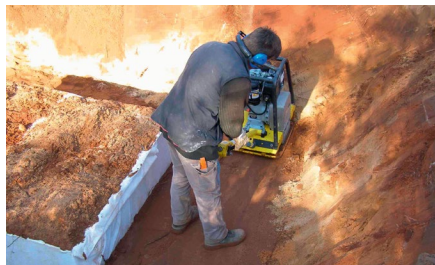
Compactage de l'espace de travail à côté du bassin.
