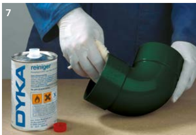
7 Nettoyer l'intérieur du raccord
